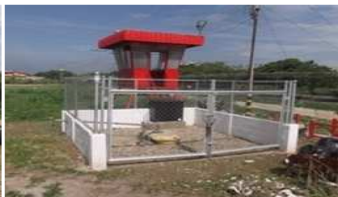
Pozo N° 2 de Planta Corinsa
