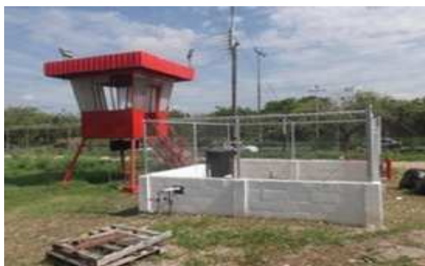
Pozo N° 2 de Planta Corinsa
